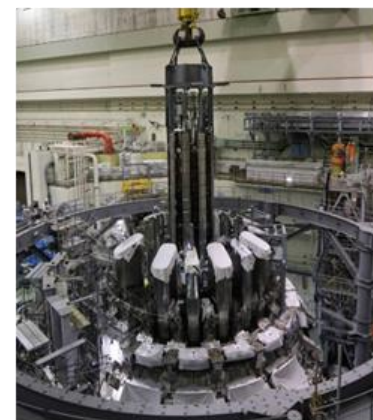
組み立て中のJT-60SA (中心ソレノイドを挿入中)
